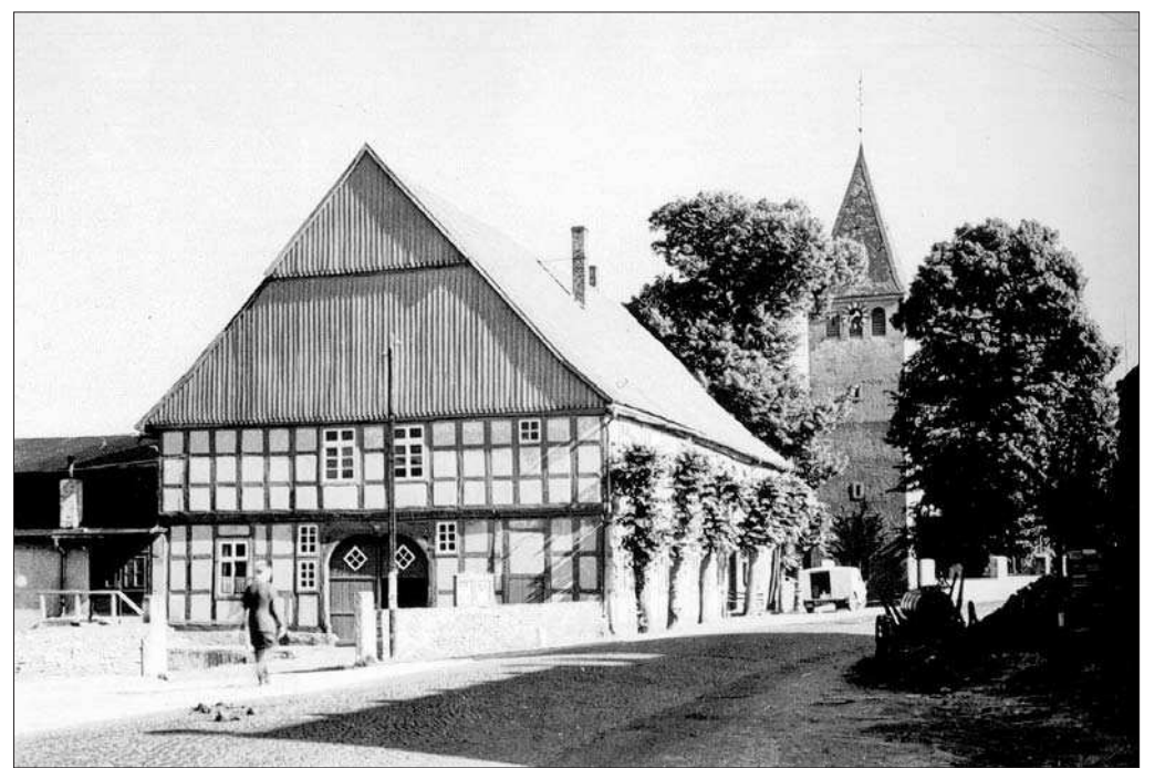
Die Ortsdurchfahrt Höhe Gieseke-Asshorn mit der katholische Kirche im Hintergrund.
