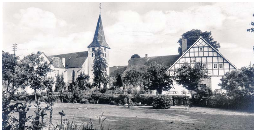
Bei der Renovierung der Lintorfer Kirche wurden überflüssige Anbauten entfernt.
